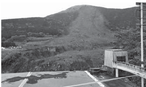
阿蘇大橋崩落現場(南阿蘇村)
