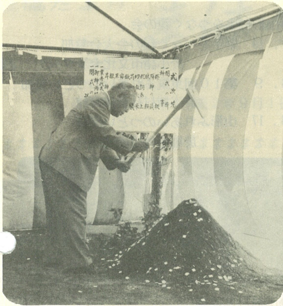
▲施設建設起工式の執行
